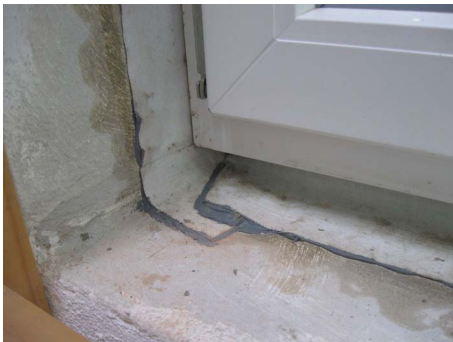
Bild 2 Raumseitige Abdichtung mit D-A-2 Folie, Detail untere Eckausbildung.
