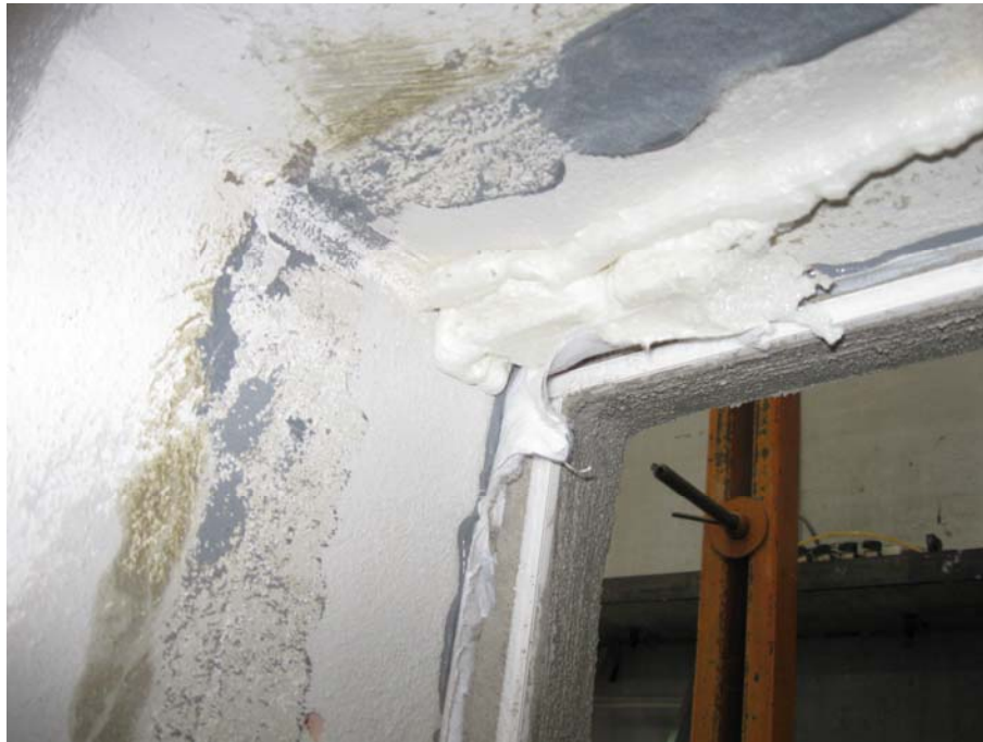
Bild 4 Obere Eckausbildung (Fenster ausgebaut).
