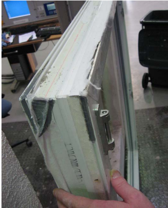
Bild 5 Obere Eckausbildung (Fenster ausgebaut). Blendrahmennuten in den Ecken mit MS-Polymer-Klebstoff verschlossen.
