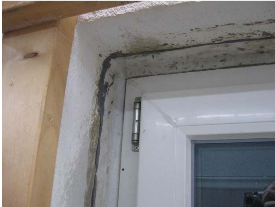
Bild 1 Raumseitige Abdichtung mit D-A-2 Folie, Detail obere Eckausbildung.
