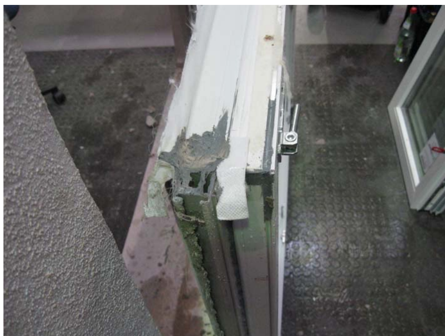
Bild 6 Untere Eckausbildung (Fenster ausgebaut). Blendrahmennuten in den Ecken mit MS-Polymer-Klebstoff verschlossen.
